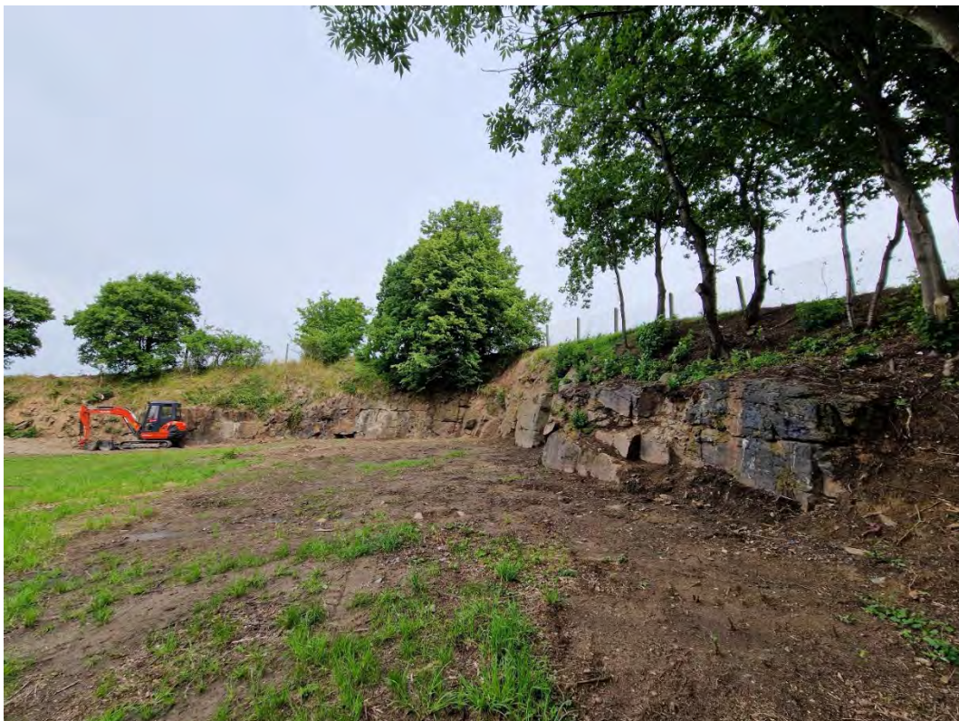
Blick von Süden, Felswand
